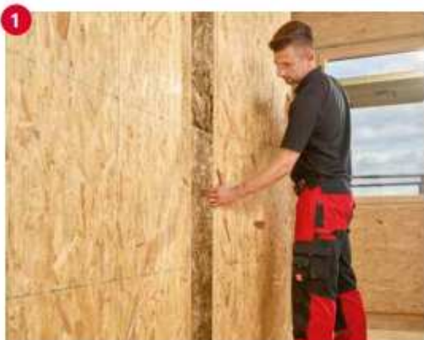
(Bild 15): Richten Sie das Ergo Board vertikal aus.
