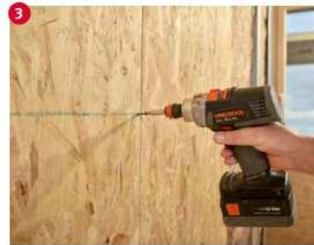
(Bild 17): Befestigen Sie das erste Ergo Board mit einem Befestigungsmittelabstand von 150 mm
