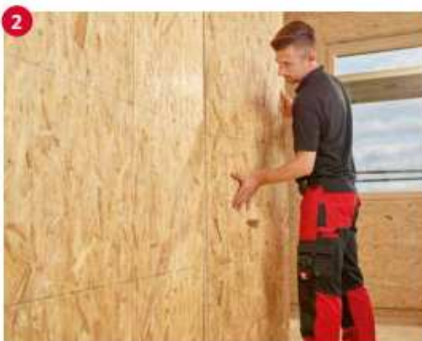
(Bild 16): Schieben Sie die Stufenfalzprofile ineinander.
