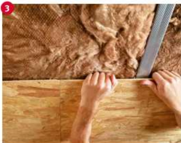
(Bild 13): Eine stabile Verbindung ist auch an nicht hinterlegten Plattenstößen durch das Nut-Feder-Profil gegeben..
