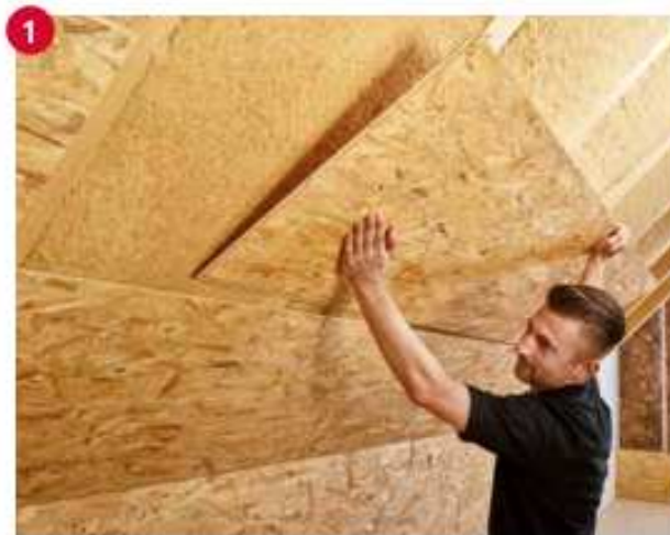
(Bild 6): Legen Sie das Ergo Board mit dem Stufenfals an der Längsseite ein. Damit sich die verschiedenen Kantenprofile in der richtigen Position befinden, muss die Markierung an der Oberseite von links nach rechts lesbar sein.
