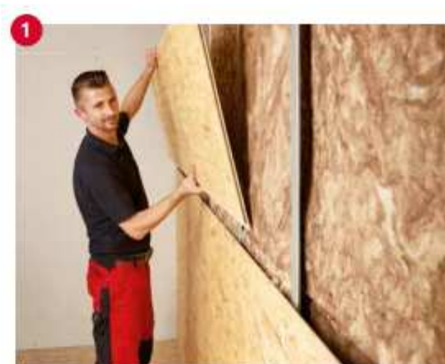
(Bild 11): Legen Sie das Ergo Board mit dem Stufenfalz an der Längsseite ein. Damit sich die verschiedenen Kantenprofile an der richtigen Position befinden, muss die Markierung auf der Oberfläche von links nach rechts lesbar sein.
