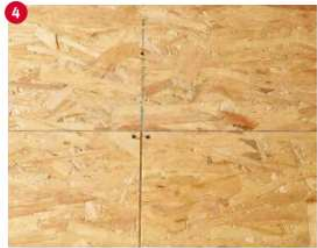
(Bild 9): Verlegen Sie das Ergo Board mit versetzten T-Stößen.
