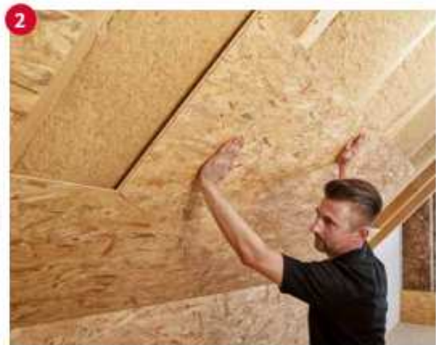
(Bild 7): Verwenden Sie das Nagelraster, um die richtige Position zu finden.
