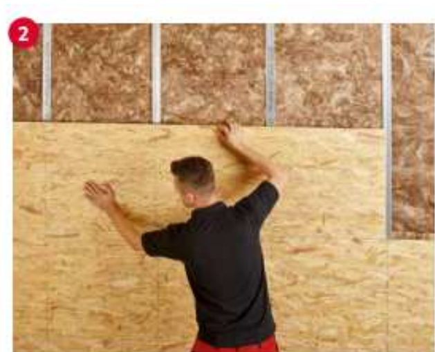
(Bild 12): Schieben Sie die Platte in die richtige Position, das Nut-Feder an der kurzen Seite in einander greifen.
