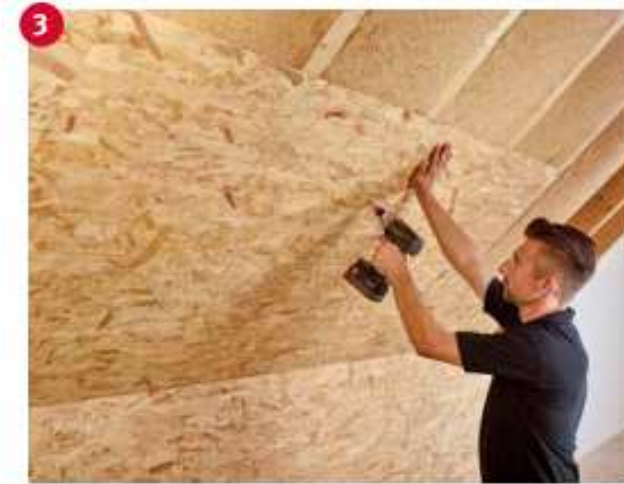
(Bild 8): Befestigen Sie das Ergo Board. Es wird durch die Kantenprofilierung sicher in Position gehalten.
