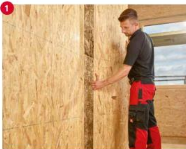
1 Richten Sie das Ergo Board vertikal aus.
