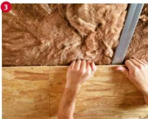
3 Eine stabile Verbindung ist auch an nicht hinterlegten Plattenstößen durch das Nut-Feder-Profil gegeben..
