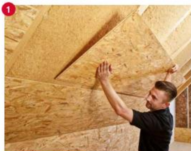
1 Legen Sie das Ergo Board mit dem Stufenfals an der Längsseite ein. Damit sich die verschiedenen Kantenprofile in der richtigen Position befinden, muss die Markierung an der Oberseite von links nach rechts lesbar sein.
