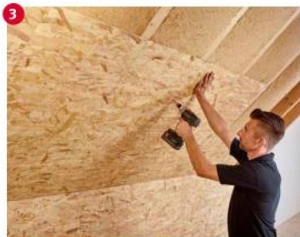
3 Befestigen Sie das Ergo Board. Es wird durch die Kantenprofilierung sicher in Position gehalten.
