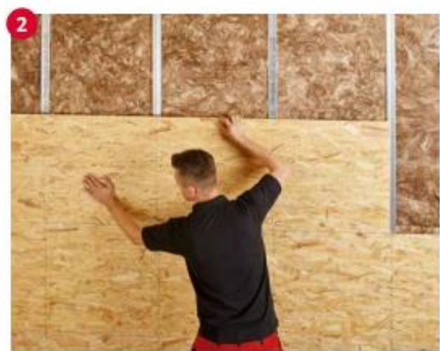
2 Schieben Sie die Platte in die richtige Position, das Nut-Feder an der kurzen Seite in einander greifen.
