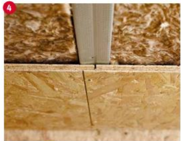
4 Befestigen Sie die aufrecht ineinander gefügten Ergo Board Platten im Stufenfalzbereich mit einer Schraube ins Ständerwerk
