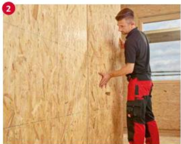
2 Schieben Sie die Stufenfalzprofile ineinander. Die zweite Platte wird nun in Position gehalten
