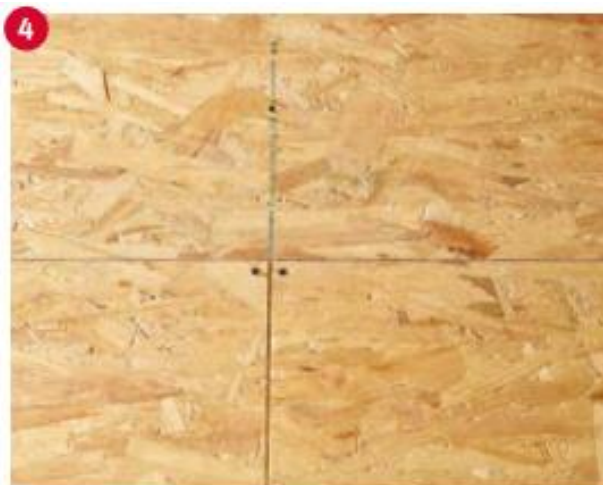
4 Verlegen Sie das Ergo Board mit versetzten T-Stößen.
