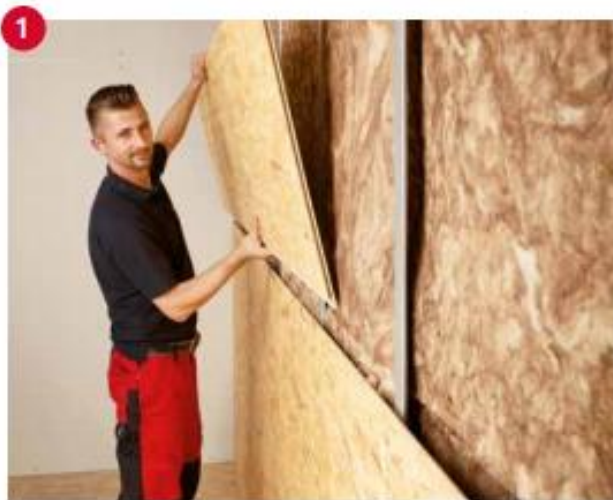
1 Legen Sie das Ergo Board mit dem Stufenfalz an der Längsseite ein. Damit sich die verschiedenen Kantenprofile an der richtigen Position befinden, muss die Markierung auf der Oberfläche von links nach rechts lesbar sein.
