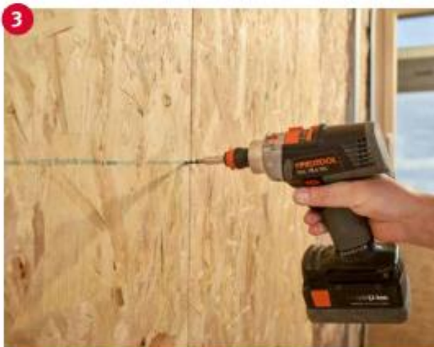
3 Befestigen Sie das erste Ergo Board mit einem Befestigungsmittelabstand von 150 mm
