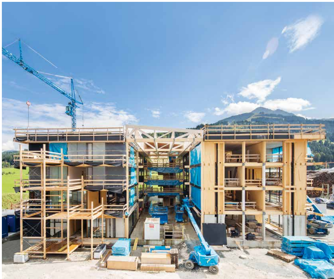
La nuova sede di EGGER a St. Johann in Tirolo (AT) durante la fase costruttiva: l'edificio amministrativo realizzato con materiali propri ospita oltre 250 dipendenti.
