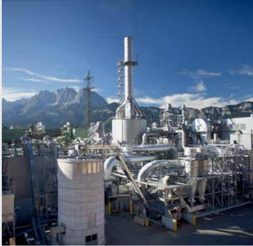
Der Holzrockner im EGGER-Werk St. Johann dient dank ausgeklügelter Abluftreinigung als saubere erneuerbare Wärmequelle für die umliegenden Gemeinden. Die Anbindung an das Fernwärmenetz gewährleistet, dass selbst der Energiegehalt von stofflich nicht nutzbaren Holz- und Produktionsabfällen voll ausgeschöpft wird.
