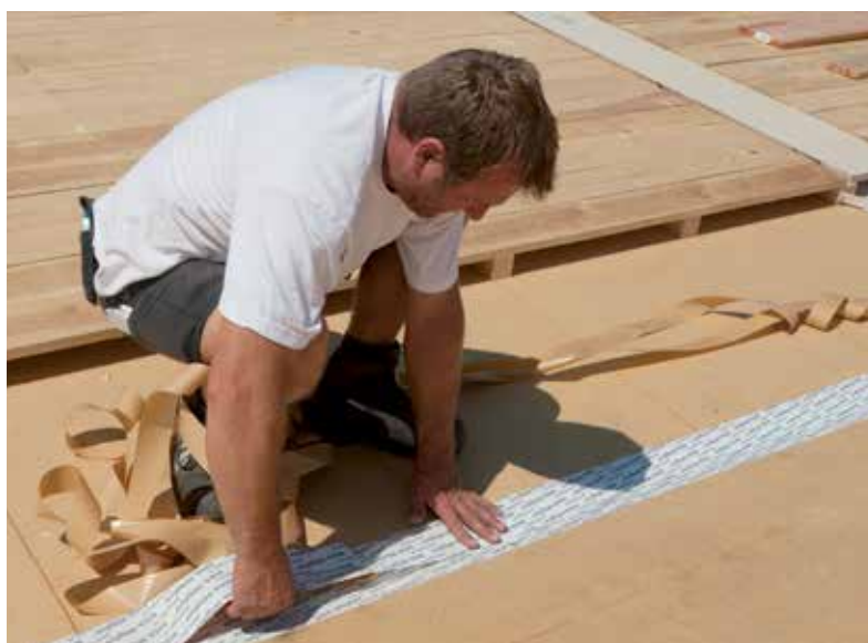
DHF ploča predstavlja zaštitnu podlogu čak i u slučaju malog nagiba krova.
