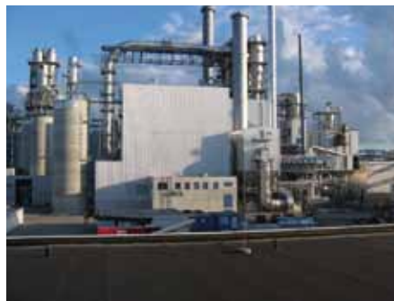
WISMAR (DE) , seit 1999, Ausbau 2006, Feuerungswärmeleistung: 80 MW Dampfleistung: 101 t/h
