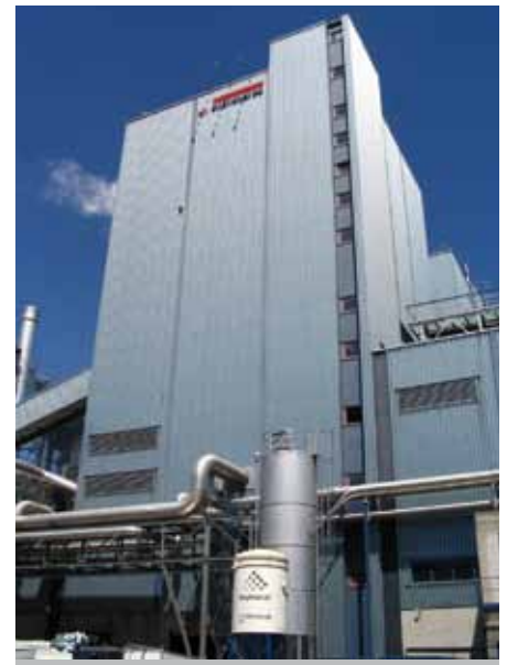
BRILON (DE) , seit 1991, Ausbau 1993 und 1996, Feuerungswärmeleistung: 150 MW Dampfleistung: 165 t/h
